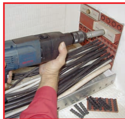
Уплотнение системы при помощи компрессионного блока K-120 (использовать бормашину).
